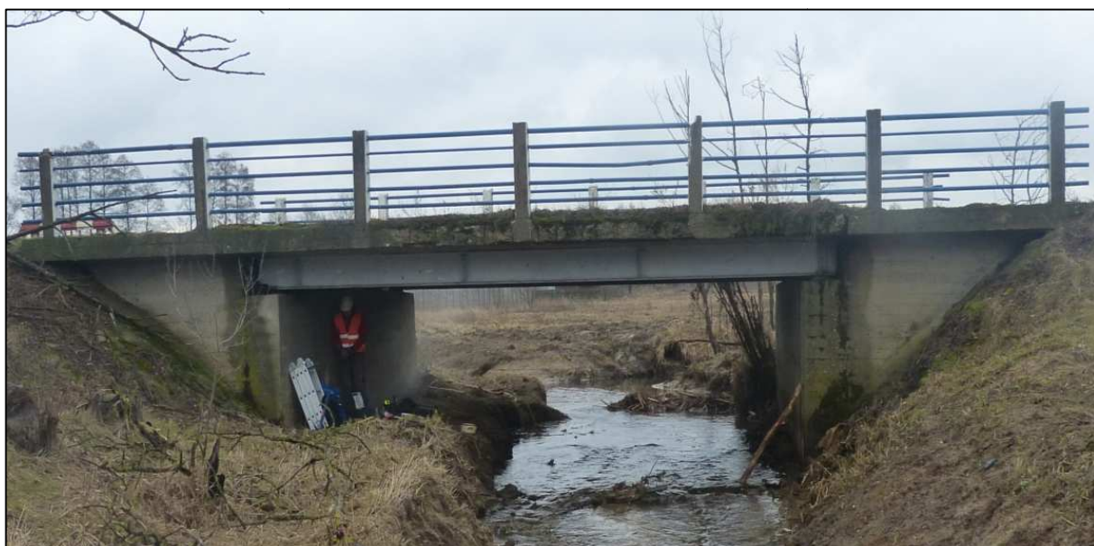
Rys. 1.2 Widok na obiekt od strony wody górnej
