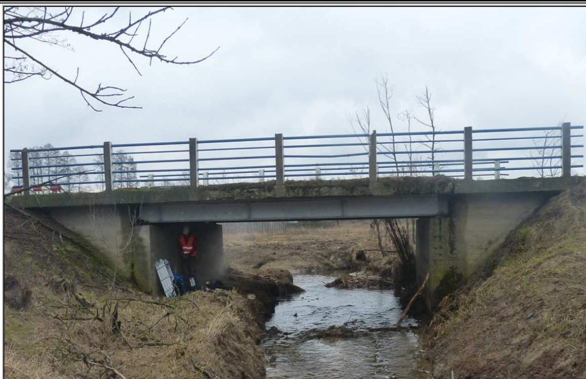
Rys. 2.1 Widok na obiekt od strony wody dolnej
